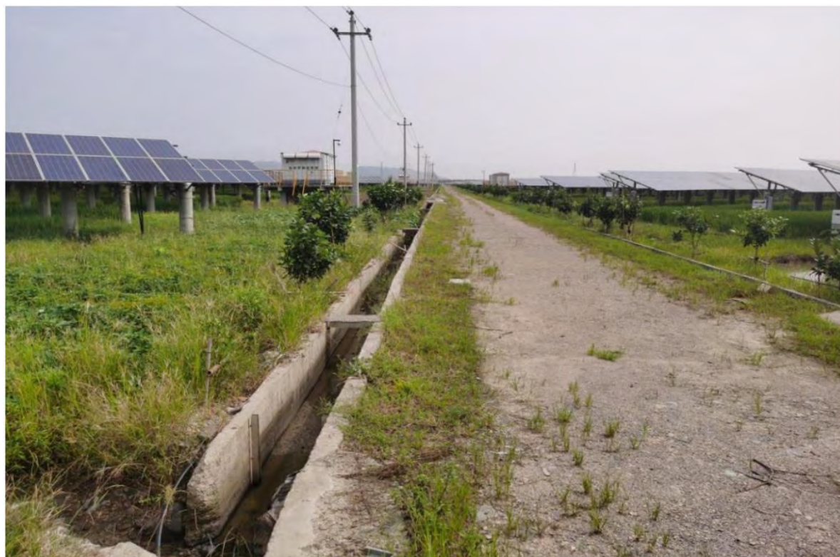
图 6 道路两侧排水沟
