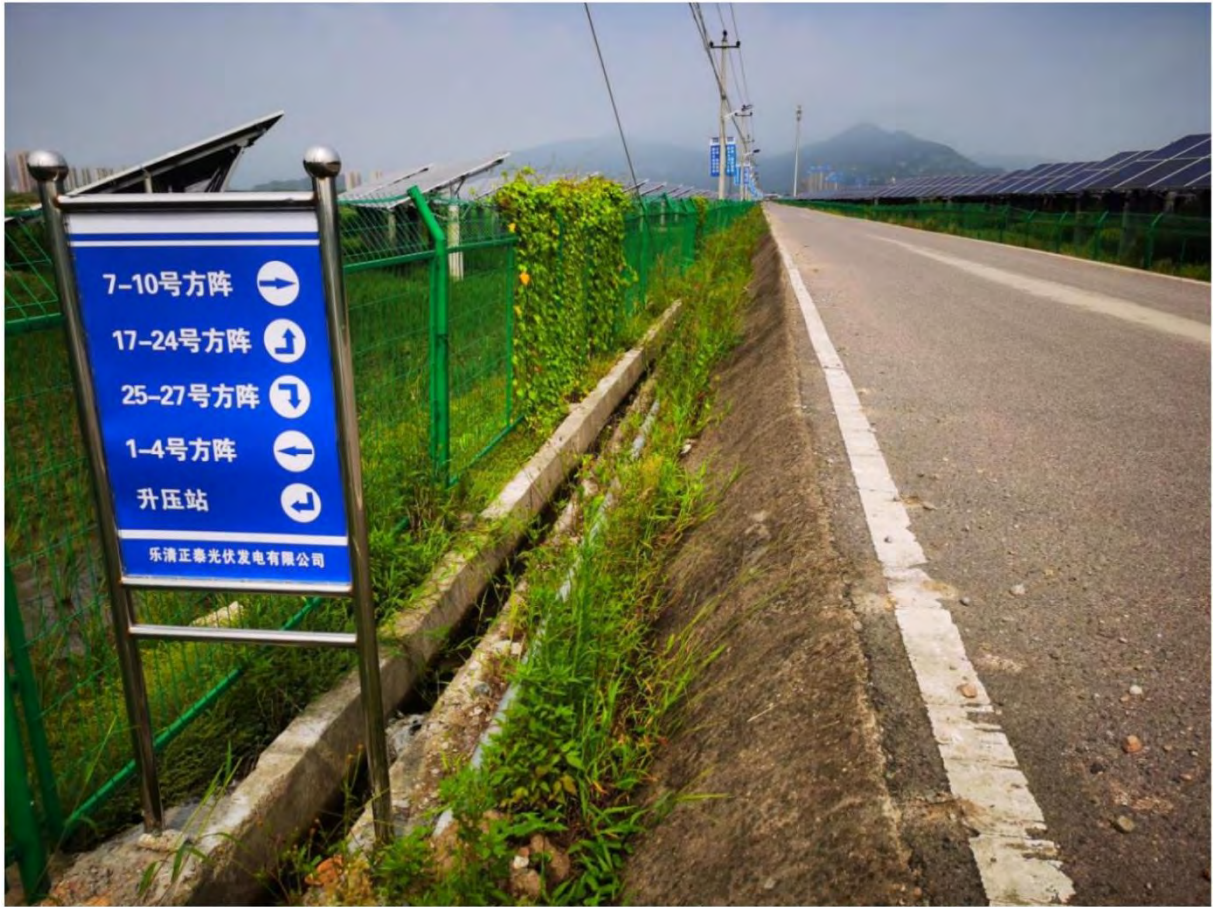
图 7 道路两侧排水沟
