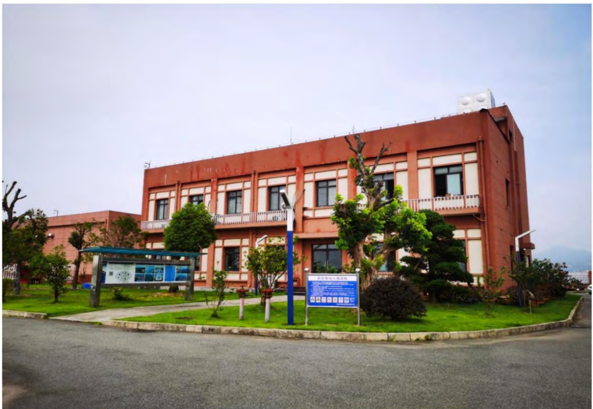
图 10 升压站内绿化
